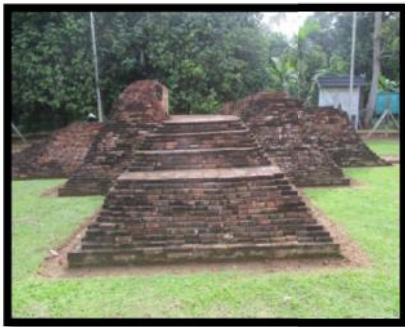
Pintu gerbang Candi Kembar Batu tampak belakang
