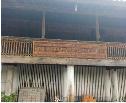
Gambar 1. Rumah Limas Seratus Tiang Desa Sugih Waras OKI (Sumber: Dokumentasi Pribadi, Mei 2021)
