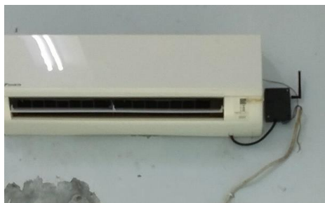
Gambar 4. Perangkat monitoring daya Listrik yang sudah dipasang pada Air Conditioner (AC)
