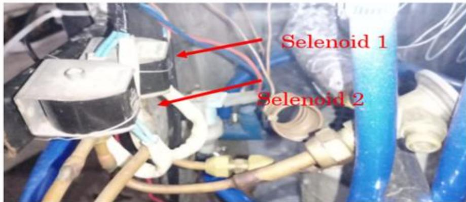
**Gambar 4. Selenoid Ekspansi dan Selenoid Kapiler**
