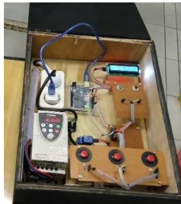
Gambar 5. Gambar bagian elektronika yang ada di dalam box panel
