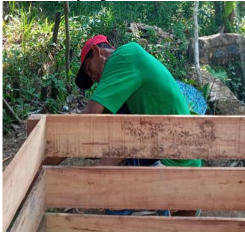
Gambar 2. Proses pembuatan kolam tarpaulin
