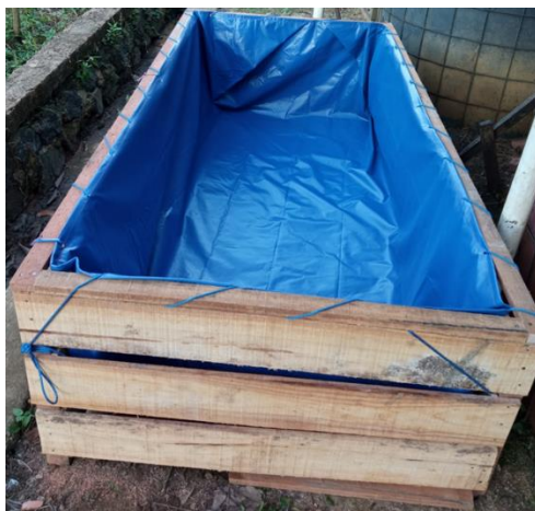
Gambar 3. Kolam tarpaulin yang telah dibuat
