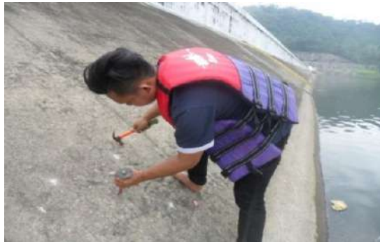
Gambar 11. Chipping untuk Pengujian Karbonasi di Area Concrete Face
