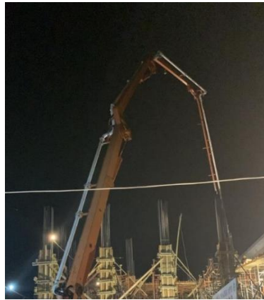
Gambar 11. Pengecoran Menggunakan Concrete Pump
