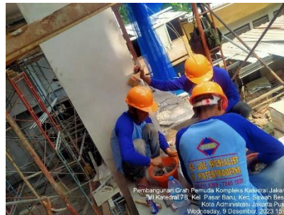
Gambar 9. Pencampuran Adukan
