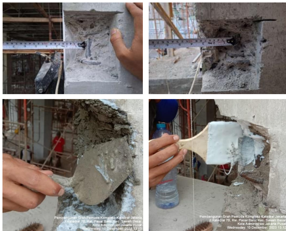
Gambar 7. Perbaikan Kolom
