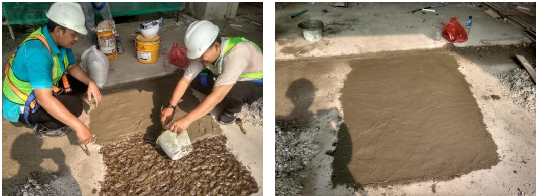
Gambar 8. Proses Penambalan dan Hasil Perbaikan
