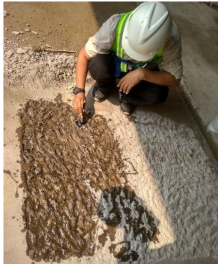
Gambar 7. Pelapisan Sikadur 752
