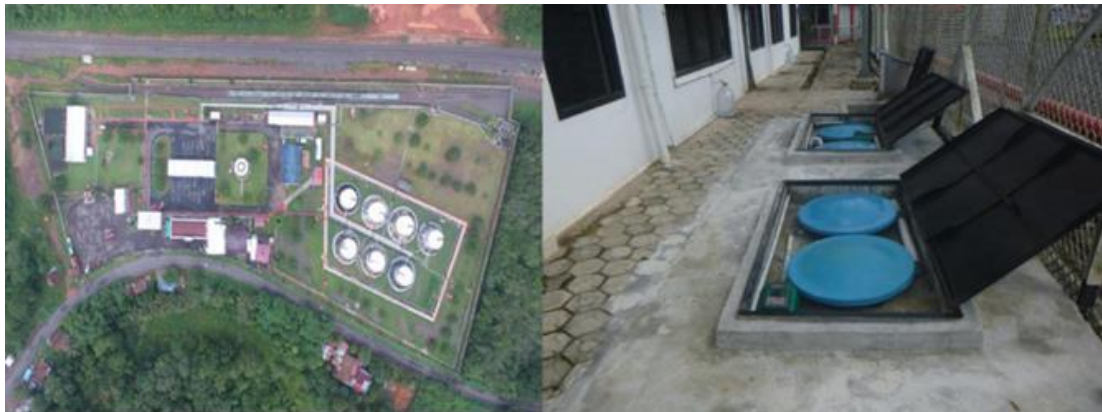
Gambar 1. Lokasi IPAL Domestik di PT Pertamina Patra Niaga Fuel Terminal Baturaja.
