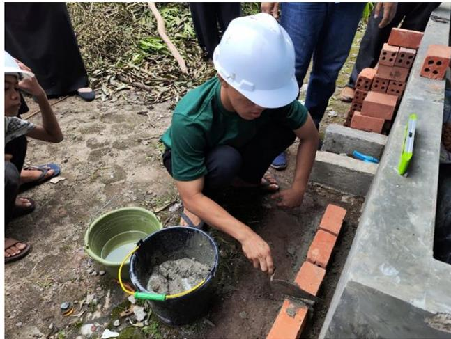
Gambar 7. Praktek pemasangan dinding batu bata dan plesteran
