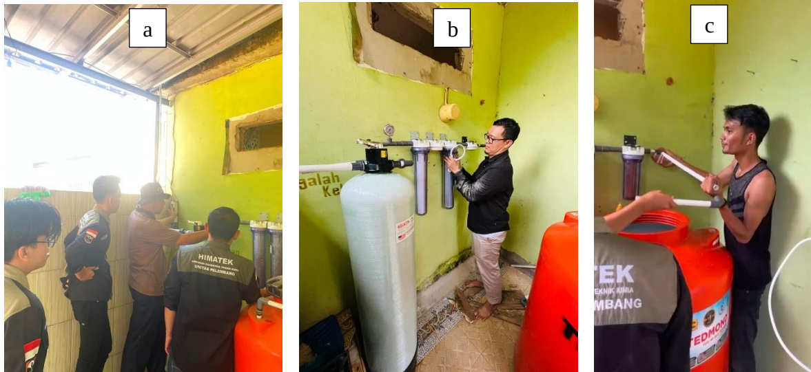
Gambar 4. Pendampingan pengoperasian alat: (a) Pelatihan pencucian (backwash) rangkaian alat filtrasi; (b dan c) Pengencangan sambungan untuk menghindari kebocoran
