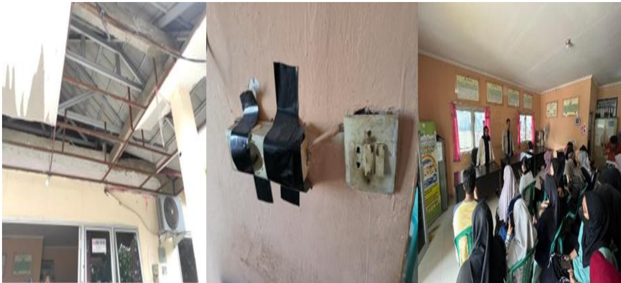
Gambar 5. Dokumentasi Kondisi Area Produksi Dan Lingkungan Kerja
