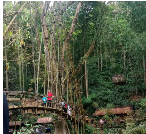
GAMBAR 4. Pemanfaatan bambu sebagai bahan dalam pembuatan jembatan
